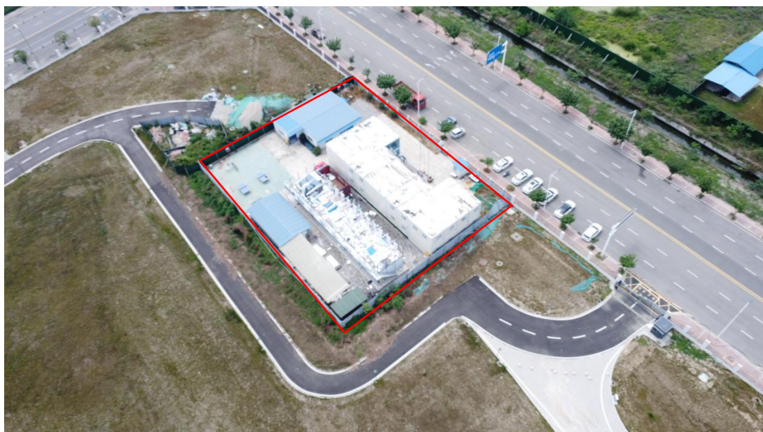
图 1.1-4 施工临建区现状照片（红色区域为延用临时办公区域）
